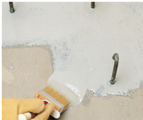
Aplikace Eporipu jako adhezního můstku štětcem
