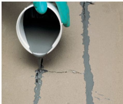
Oprava trhliny v cementovém potěru Eporipem
