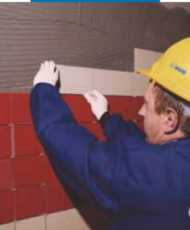
Lepení keramického obkladu shora dolů
