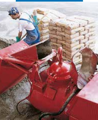
Příprava a doprava Topcem s pomocí automatického pneumatického čerpadla
