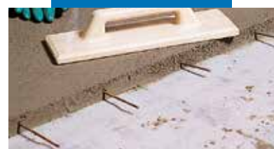
Detail potěru z Topcem s výztuží u pracovní spáry
