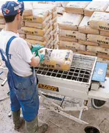
Příprava potěru Topcem v kontinuální míchačce
