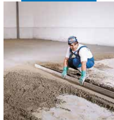
Provádění vodícího pásu
