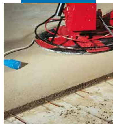
Konečná úprava povrchu Topcem rotační hladíčkou
