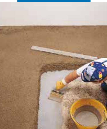
Aplikace adhezivního můstku pro kotvení pětér Topcem
