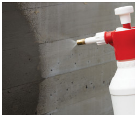
Aplikace výrobku Planiseal WR 100 nástřikem
