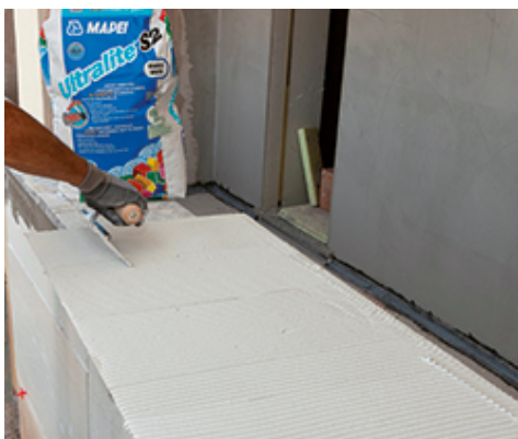
Nanášení lepidla na rubovou stranu obkladového prvku
