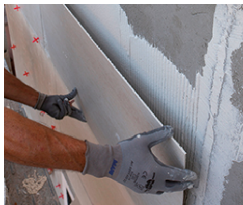
Lepení tenkovrstvého obkladu typu gres na fasádu
