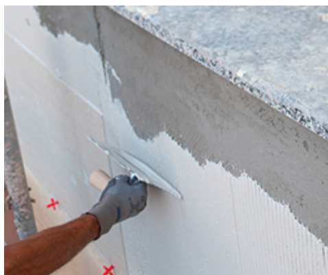
Lepení v exteriéru na fasádu: nanášení lepidla na podklad
