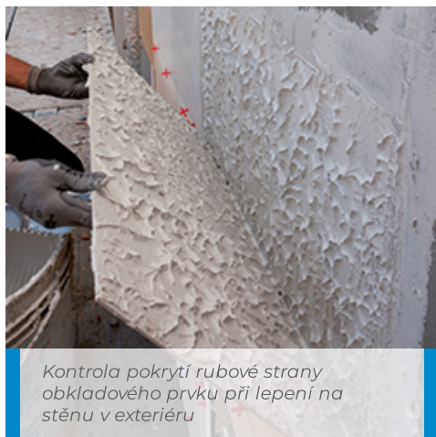
Lepení v exteriéru na fasádu: nanášení lepidla na podklad
