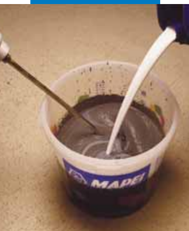
Míchání Planipatch s emulzí Latex Plus pro vyhlazení / vyrovnání složitých nebo deformovatelných podkladů
