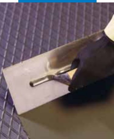
Planipatch smíchaný s Latexem Plus při vyrovnání povrchu ocelového plechu
