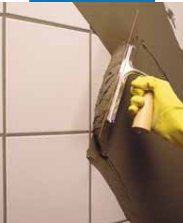
Vyhlazování stávajícího obkladu tmelem Planipatch
