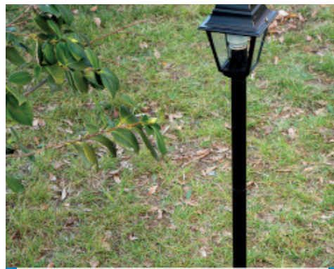
Kotvení sloupu pouličního osvětlení s použitím výrobku Mapegrout Ancora & Ripara
