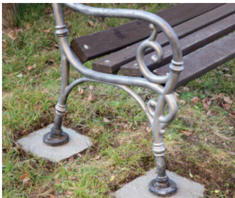
Kotvení lavičky s použitím výrobku Mapegrout Ancora & Ripara
