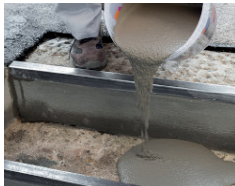
Oprava betonového schodišťového stupně s použitím výrobku Mapegrout Ancora & Ripara
