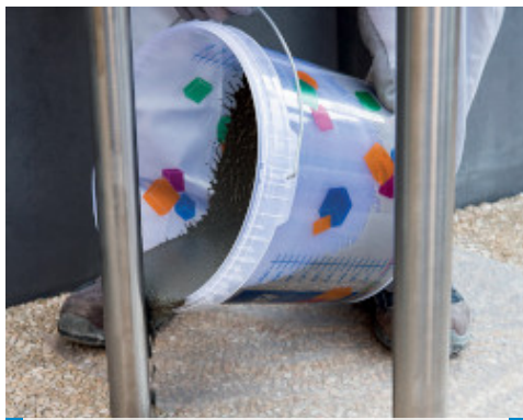
Kotvení prvku městského mobiliáře s použitím výrobku Mapegrout Ancora & Ripara
