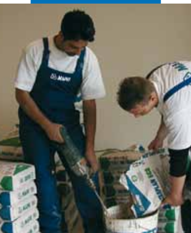
Míchání Ultraplanu Eco - mateřská školka Mirabello, Cantù (Como), Itálie
