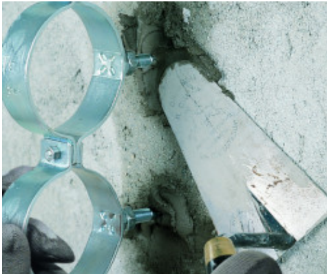
Osazení potrubních objímek s použitím Lampocemu
