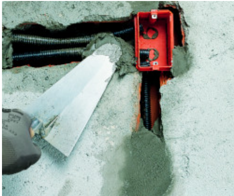
Fixace instalačních krabic a rozvodů elektro s použitím Lampocemu
