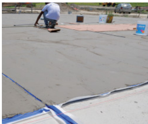
Hydroizolace potěru Mapelasticem a Mapebandem
