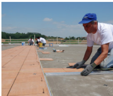
Pokládka keramiky Kerabondem + Isolasticem
