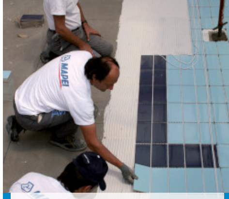
Pokládka keramické dlažby na podklad z Mapelastice v bazénu
