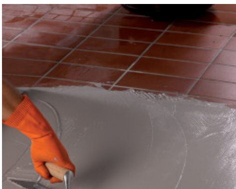
Nanášení druhé vrstvy Monolasticu na MapeNet 150
