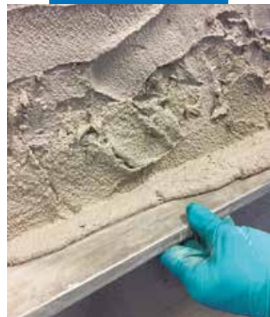
Vyrovňování povrchu čerstvé omítky PoroMap Deumidificante stahovací latí
