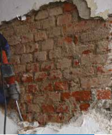
Odstranění stávající omítky
