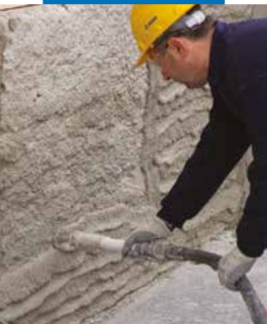
Aplikace PoroMapu Deumidificante strojní omítačkou
