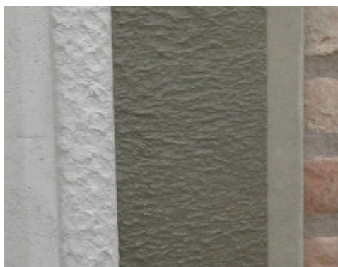
Aplikace PoroMapu Rinzaŕfo Plus na Mapelastíc Foundation ke zhotovení antikondenzačního systému
