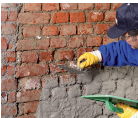
Aplikace omítky PoroMap Rinzaŕfo Plus zednickou lžící
