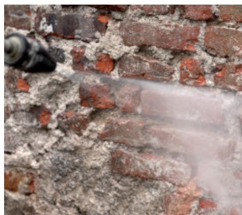
Oplach zdiwa tlakovou vodou
