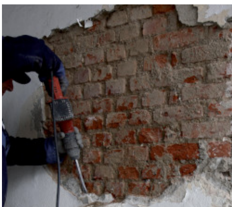
Odstranění degradované omítky
