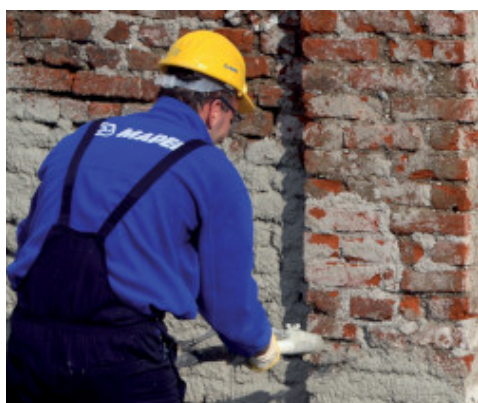
Aplikace omítky PoroMap Rinzaŕfo Plus strojní omítačkou
