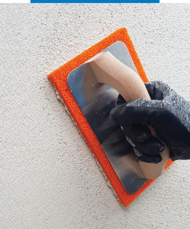
Dokončování povrchu malty PoroMap Finitura Granello houbovým hladítkem
