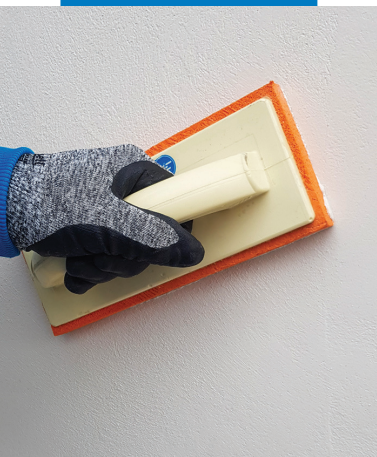
Dokončování povrchu malty PoroMap Finitura Civile houbovým hladítkem
