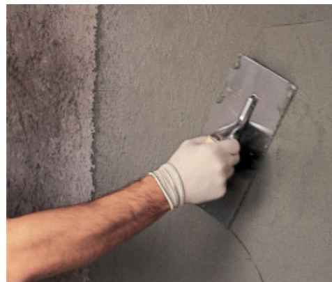
Vyhlazení povrchu Planitop 540 ocelovým hladítkem
