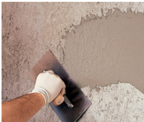
Aplikace malty Planitop 540 ocelovým hladítkem
