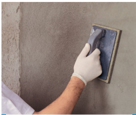
Konečná úprava povrchu Planitop 540 houbovým hladítkem
