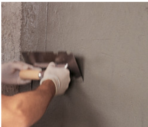
Aplikace malty Planitop 540 ocelovým hladítkem
