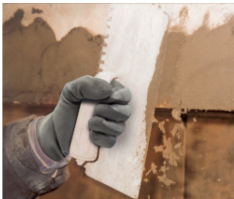
Oprava čela betonové desky balkonu: dokončení
