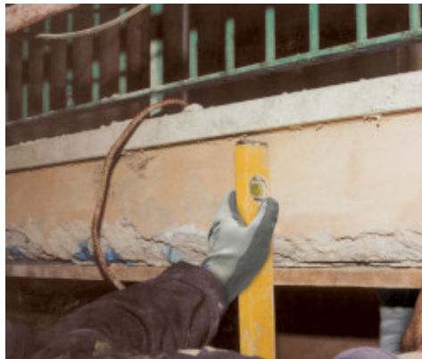
Oprava čela betonové desky balkonu: umístění dřevěného bednění
