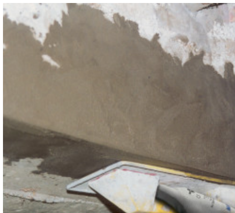
Lokální oprava betonového nosníku
