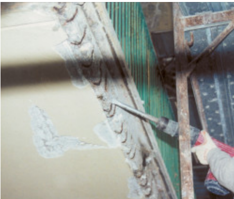
Oprava čela betonové desky balkonu: příprava podkladu
