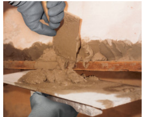
Oprava čela betonové desky balkonu: aplikace Planitopu 400
