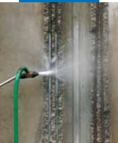
Čištění ocelové výztuže
