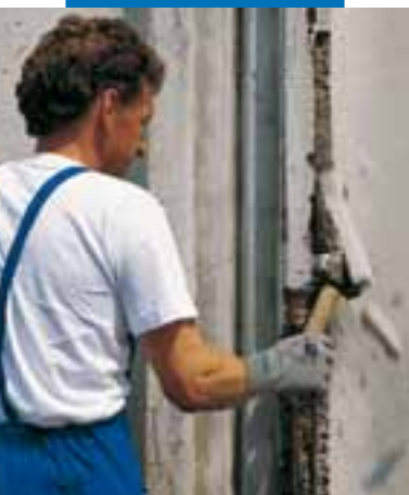
Odstraňování poškozeného betonu
