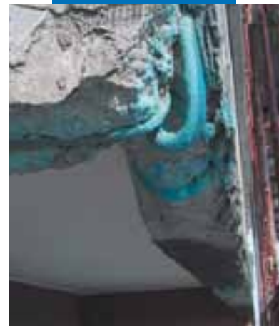
Pruty výztuže v přední části balkonu ošetřené Mapeferem 1K
