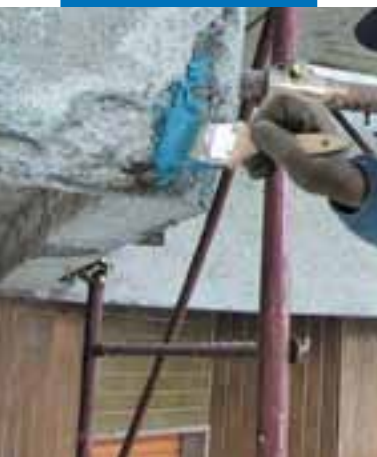
Aplikace Mapeferu 1K štětcem na odkrytou výztuž železobetonové konstrukce balkonu
