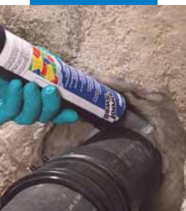
Aplikace Mapeproofu Swell okolo potrubí
