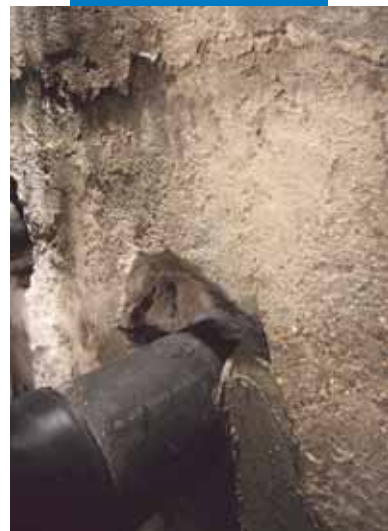
Ohraničení Mapeproofu Swell Mapegroutem T40
