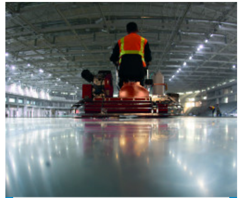
Betonová podlaha vyztužená vlákny Mapefibre ST 42
