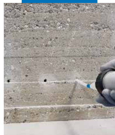
Zhotovení chemické bariéry v betonové zdi
