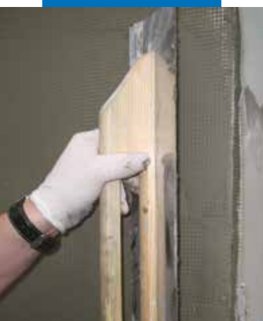
Vyrovnaní vrstvy Mapetherm AR2 s vloženou síťovinou ze skelných vláken
