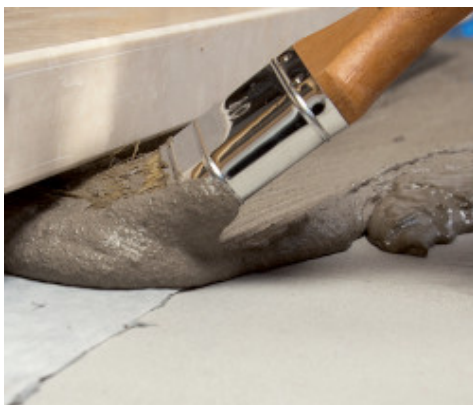
Aplikace Mapebandu SA ve špatně dostupných prostorách
