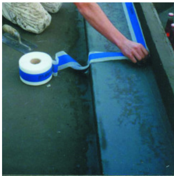
Ukázka hydroizolace přechodu mezi dnem a stěnou vany pásem Mapeband
