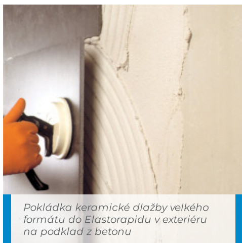
Nanášení Elastorapidu zubovou stěrkou na cementový potěr
