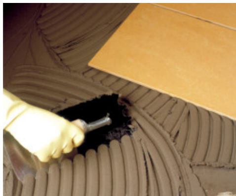
Nanášení Elastorapidu zubovou stěrkou na cementový potěr
