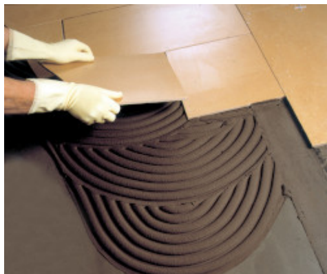
Pokládka keramické dlažby na potěr izolovaný Mapelasticem
