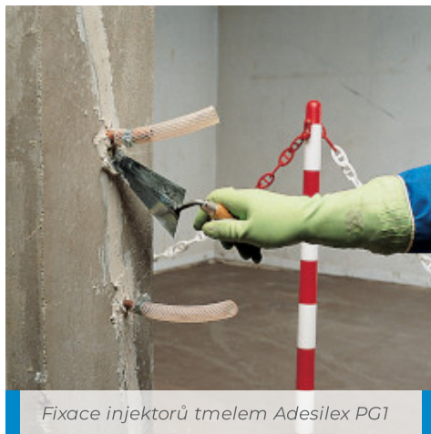
Injektáž Epojetu do sloupu s trhlínami
