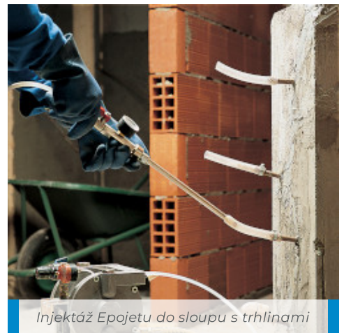
Fixace injektorů tmelem Adesilex PG1
