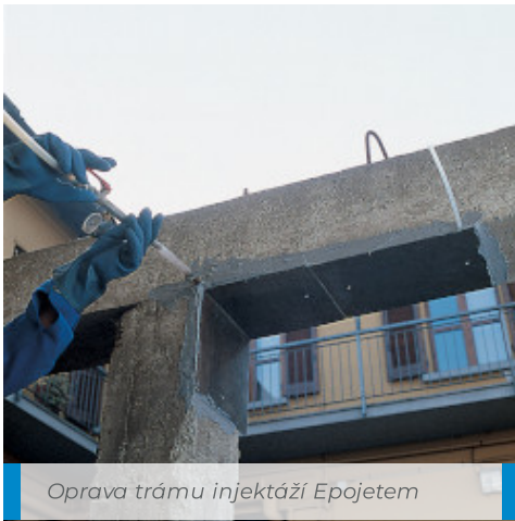
Oprava vodorovné konstrukce injektáží Epojetem
