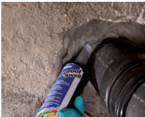
Prostupující prvek utěsněný výrobkem Mapeproof Swell
