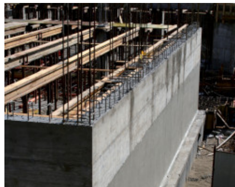
Opěrná zeď po betonáži ošetřená hydroizolací Mapelastic Foundation
