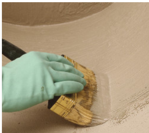
Hydroizolace detailů štětkou
