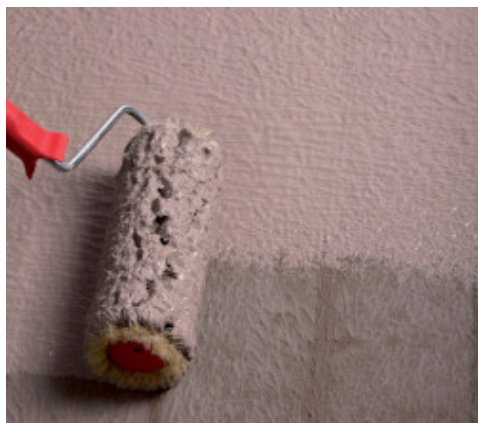
Hydroizolace detailů válečkem
