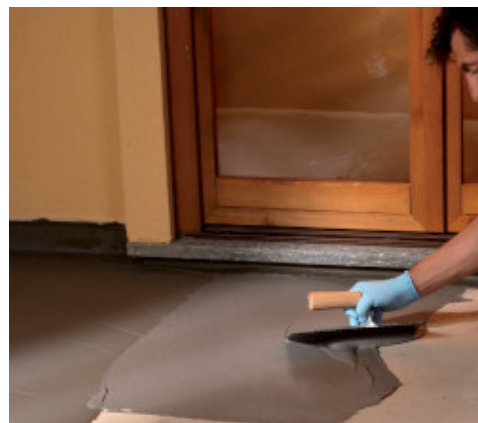
Hydroizolace terasy stěrkou
